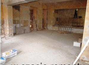
... w czasie remontu ...
