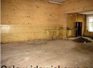
Sala widowiskowa przed remontem ...
